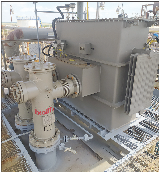
Рис. 1. Внешний вид высоковольтного трансформатора ТМД-НТ-150 с узлом ввода высокого напряжения УВВН-250В
