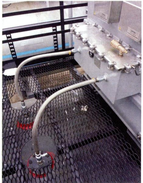
Рис. 3. Внешний вид взрывозащищенного гибкого УВВН с высоковольтным источником питания NWL OILPRC с преобразователем фаз (3:2) по схеме Скотта
